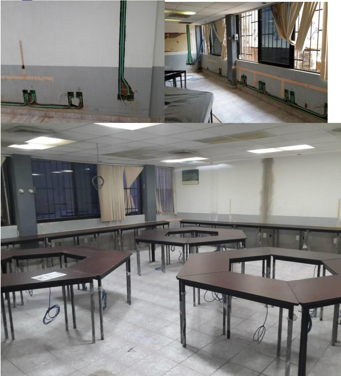
Finalmente tanto la parte eléctrica como la de datos quedan ocultas y solo se muestra los contactos eléctricos y el nodo de red para conectar el cable de red hacia el puesto alumno.
